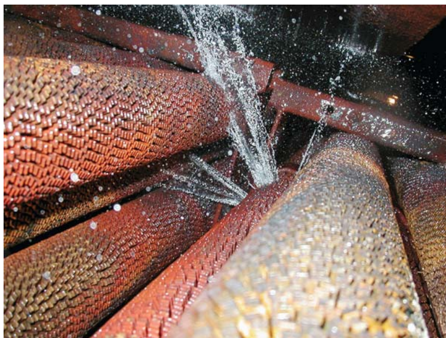
عکس اکونومایزر خوردگی و نشستی در اکونومایزر
